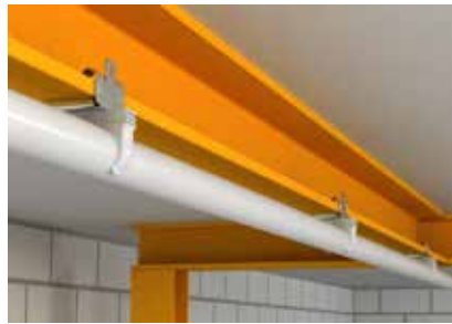
Clip di fissaggio per l'installazione di tubazioni parallele alla trave
